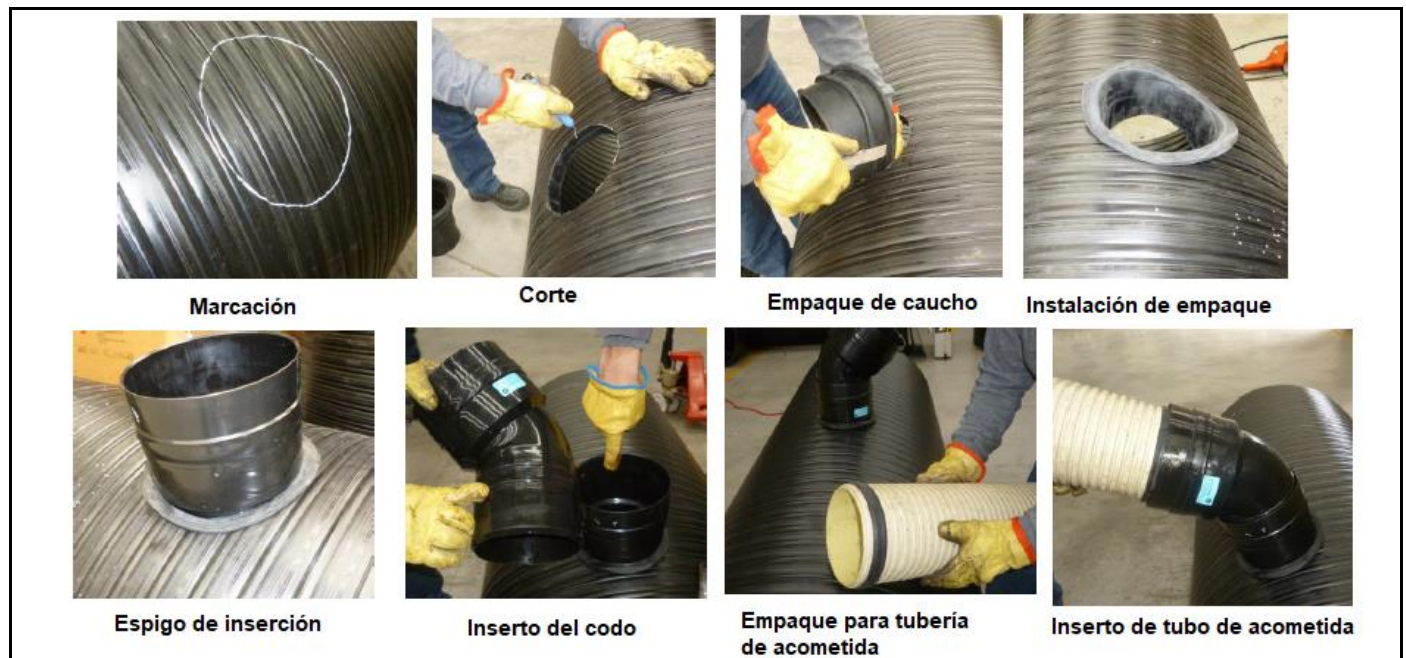
Figura 5. “kit” de instalación de acometidas de alcantarillado en tubería de polietileno
