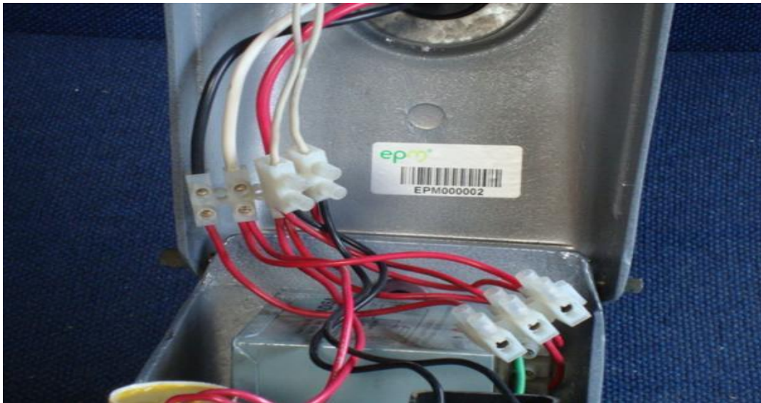
Figura 11. Pegado de Etiquetas en la Luminarias
