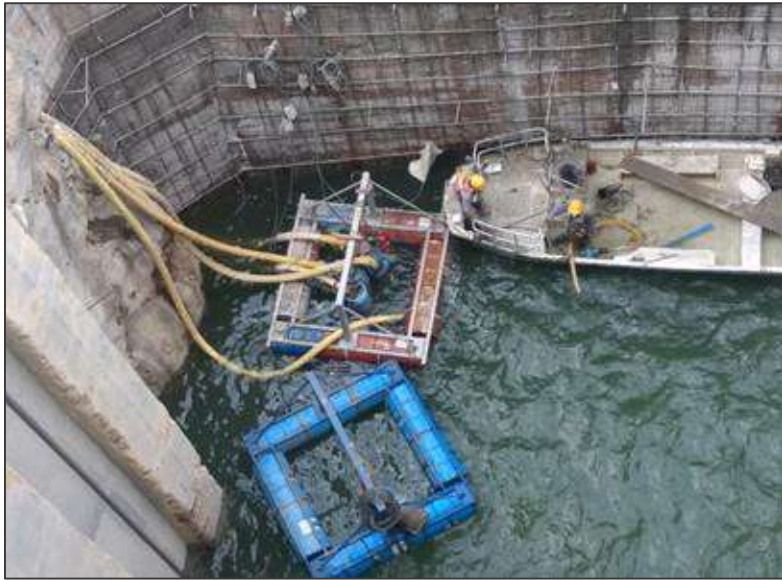
Instalación de primeras bombas en la descarga 2
