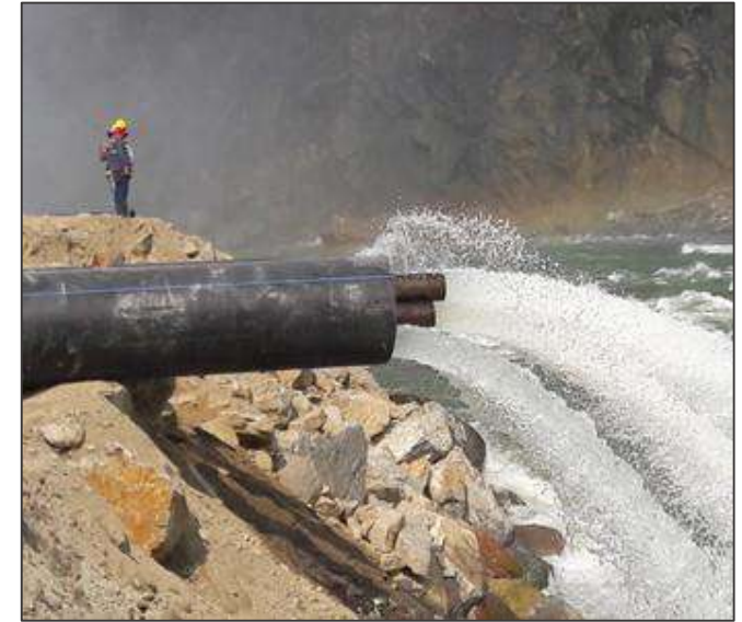
Estado actual de la actividad de evacuación de agua de casa de máquinas
