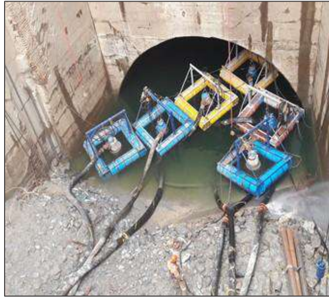
Estado actual de la actividad de evacuación de agua de casa de máquinas
