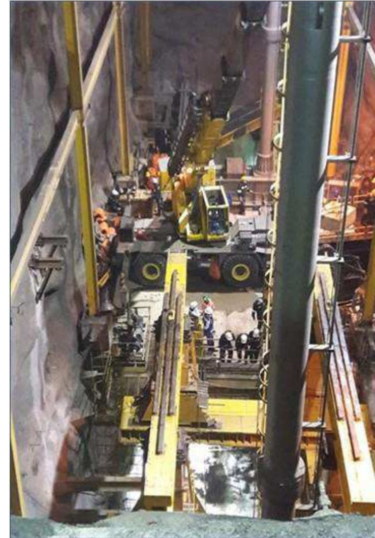
Recuperación y montaje de compuertas de desviación
