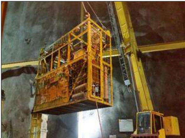
Ingreso de personal de la armada (buzos) para inmersión e inspección de las áreas a dragar
