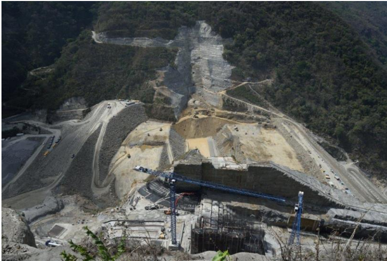
Obras civiles exteriores
