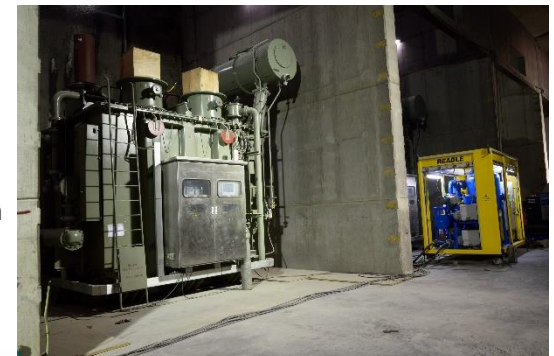
Caverna de Transformadores: Zona Norte: avance del 99% en el montaje.
