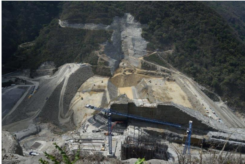
Obras civiles exteriores
