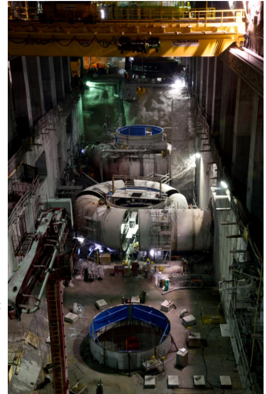
Casa de máquinas: montaje de los equipos (turbinas y generadores).
