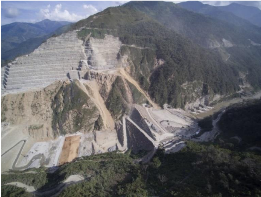
Obras civiles exteriores
