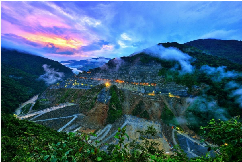
Obras civiles exteriores
