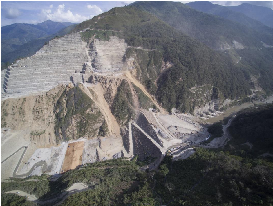
Obras civiles exteriores
