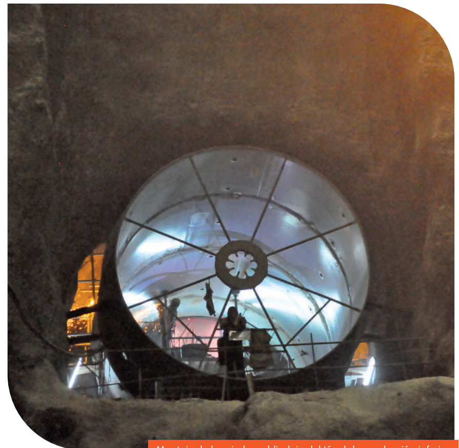
Montaje de las virolas o blindaje del túnel de conducción inferior
