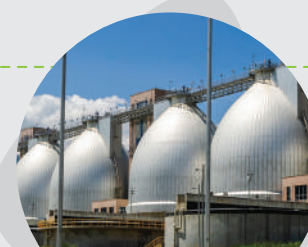
PTAR Aguas Claras
